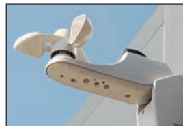
Bei vorhandenem Steuerungssystem sollte der mechanische Windsensor periodisch auf Beschädigungen durch externe Einflüsse bzw. auf seine Funktionstüchtigkeit überprüft werden (Drehverhalten bei Wind beobachten). Sollte sich der Windsensor nicht richtig drehen, muss er von einem KLAIBER Fachhändler überprüft werden.
